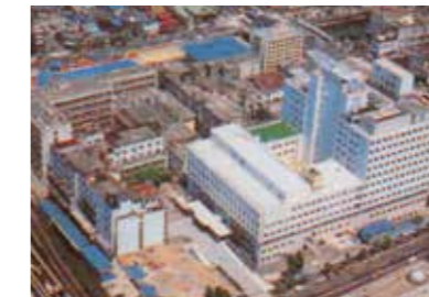
外来診療棟竣工(昭和53年)
